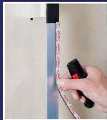
Paso 3: Colocar la cinta Foam Tape
