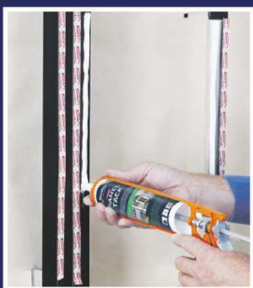
Paso 4: Aplicar el adhesivo
