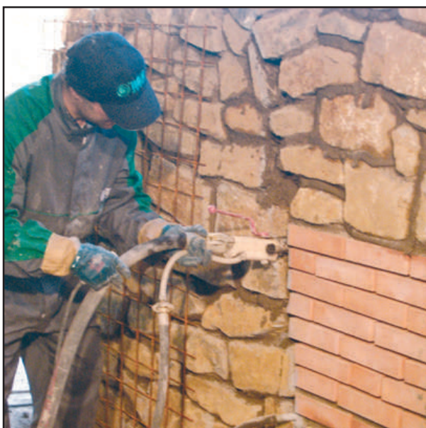
Realizar relleno de juntas
