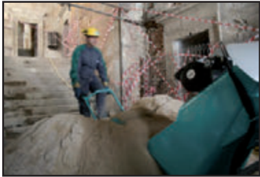
Escráper/mulilla “opcional”, de tracción hidráulica, para facilitar la carga de los materiales sobre la tolva/skip, reduciéndose el esfuerzo personal, y agilizándose el ciclo de trabajo
