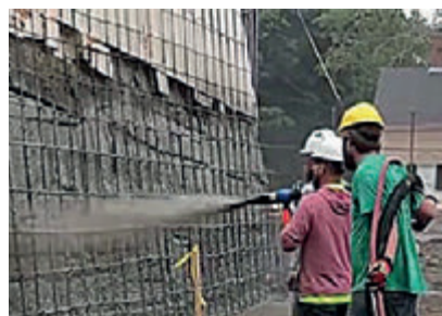
Para gunitar con kit bomba tipo 60.12 y con proyector para gutinado.
