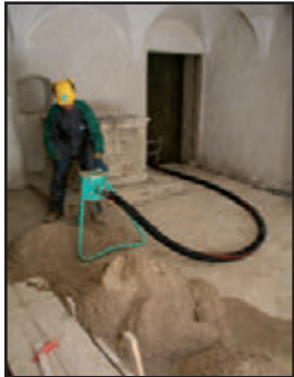
Caballete/trípode para recepción y reparto de los morteros y áridos en planta. Se suministra siempre de serie
