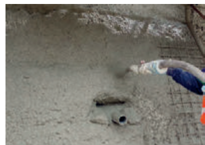
Para enfoscar morteros tradicionales premezclados y monocapas.
