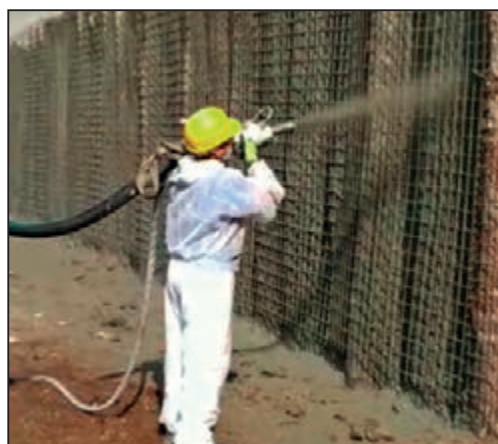
Gunita con enorme efectividad y rendimiento.
