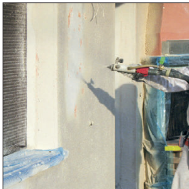
Gracias a su "INVERTER" podemos regular el caudal de los materiales, para de esta forma poder enfoscar / proyectar materiales que requieren la aplicación de una capa fina
